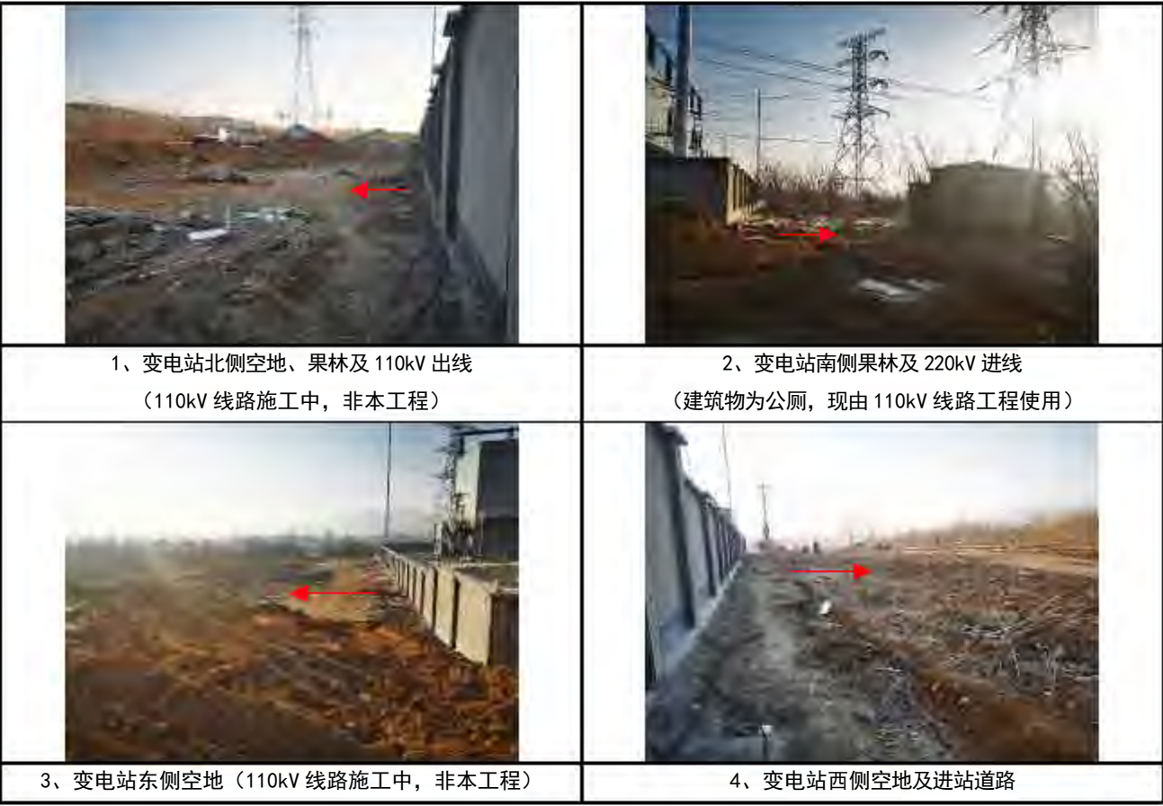
图 4-1 本工程变电站周围现场照片
