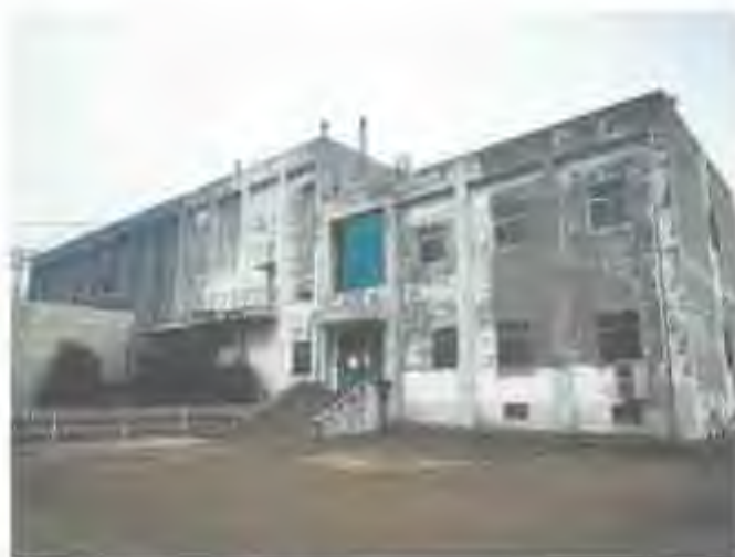
项目现场照片
