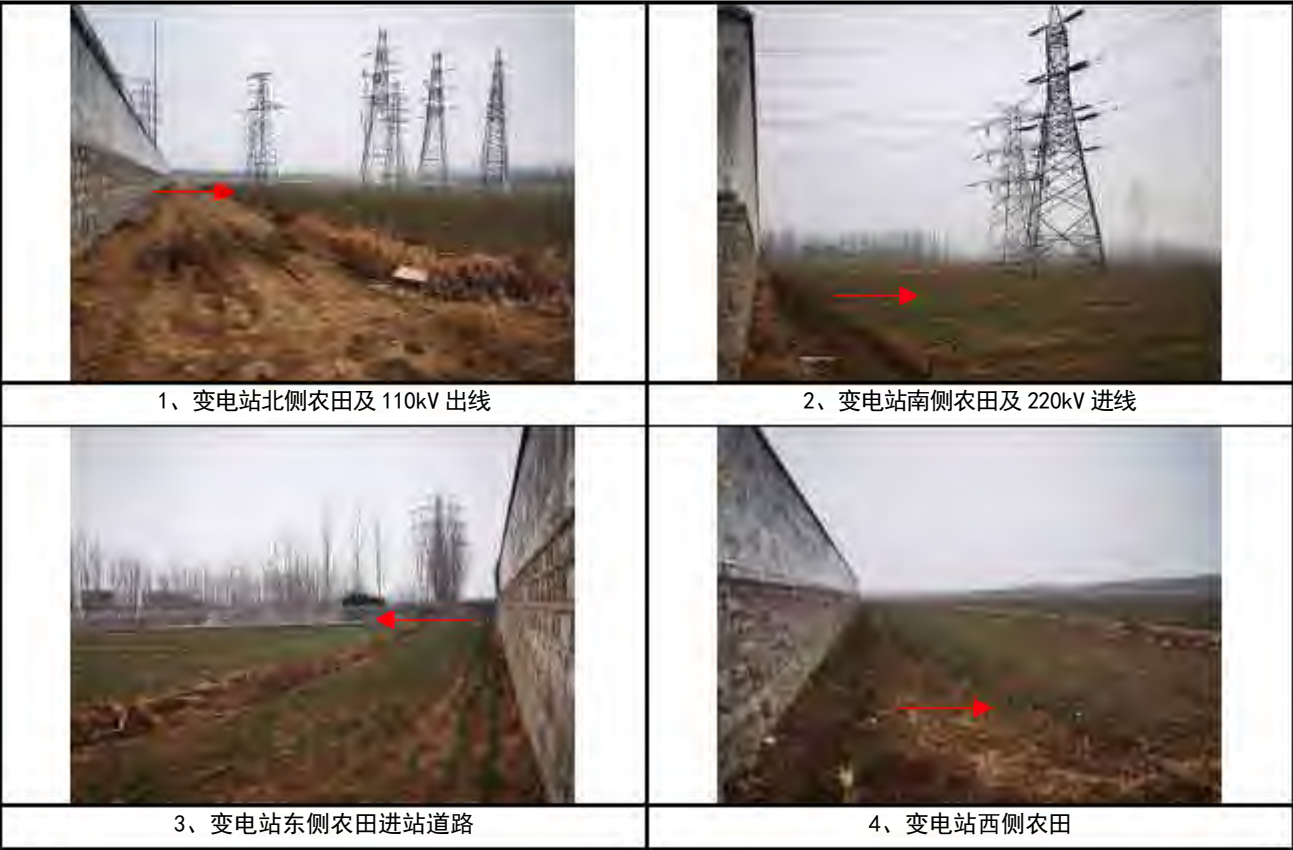
图 4-1 本工程变电站周围现场照片
