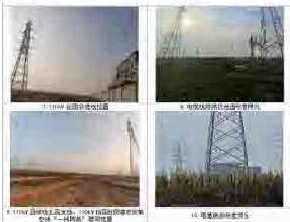
图 3-3 110kV 输电线路施工现场照片
