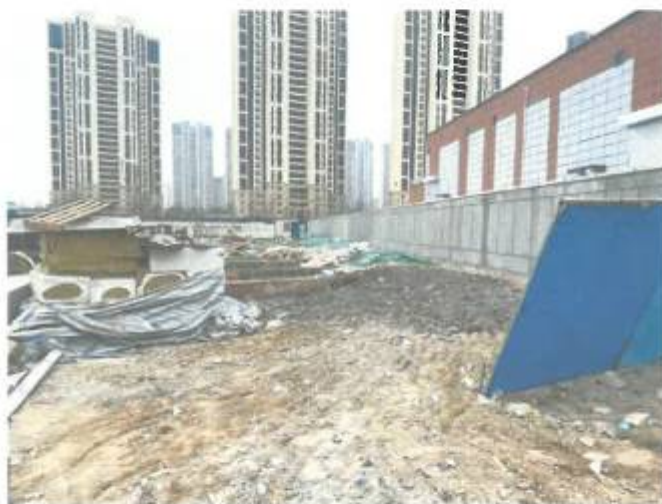
项目现场照片
