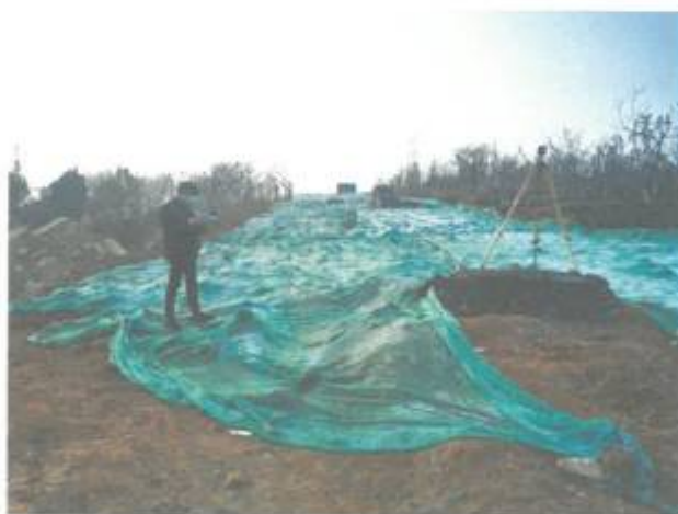
项目现场监测照片
