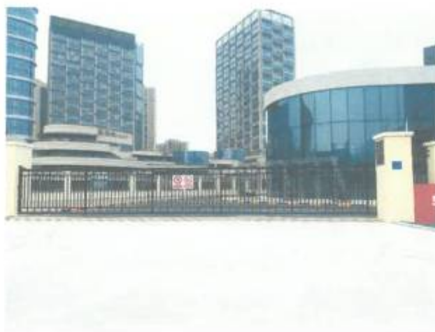
项目现场照片
