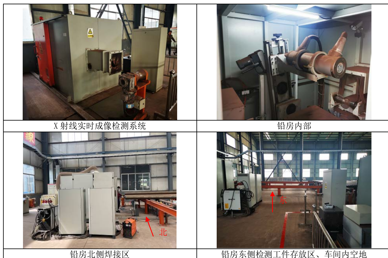
图 2-1 本次验收 X 射线实时成像检测系统现场照片
