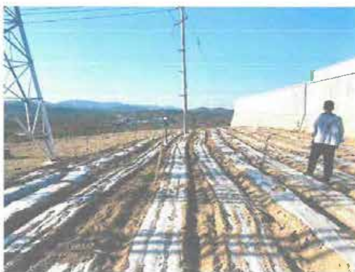
项目现场监测照片
