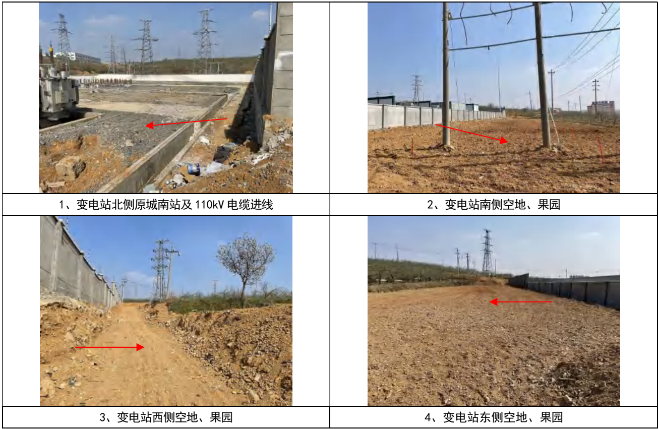
图 4-1 本工程变电站周围现场照片
