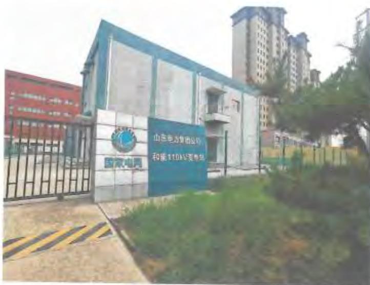
项目现场照片
