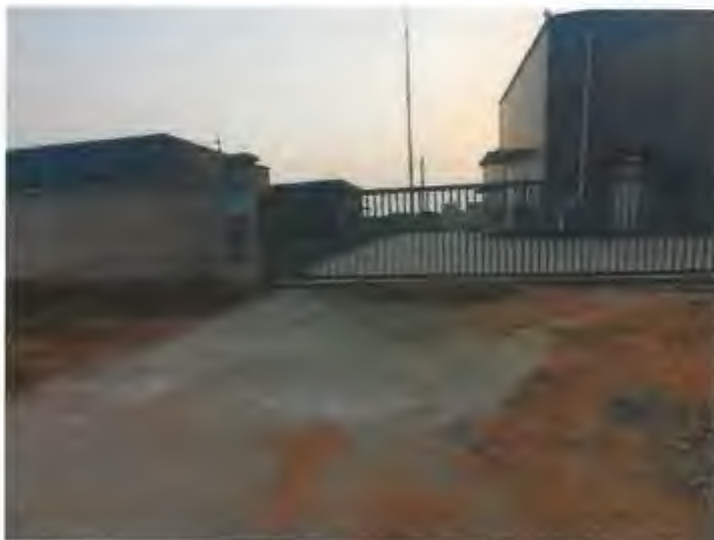
项目现场照片
