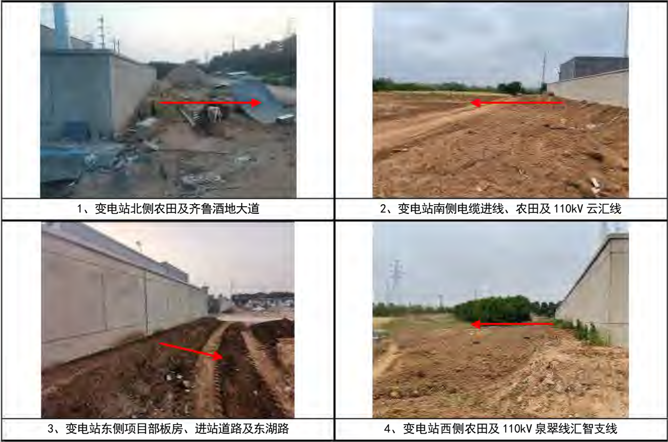
图 4-1 本工程变电站周围现场照片
