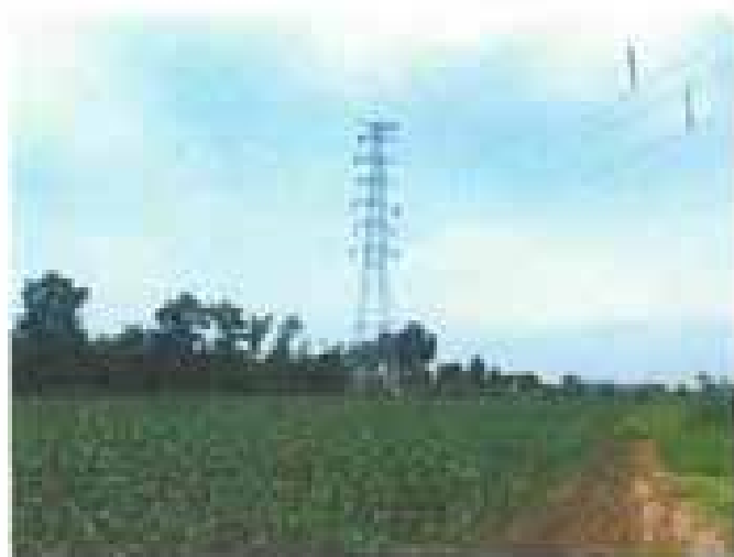
项目现场照片
