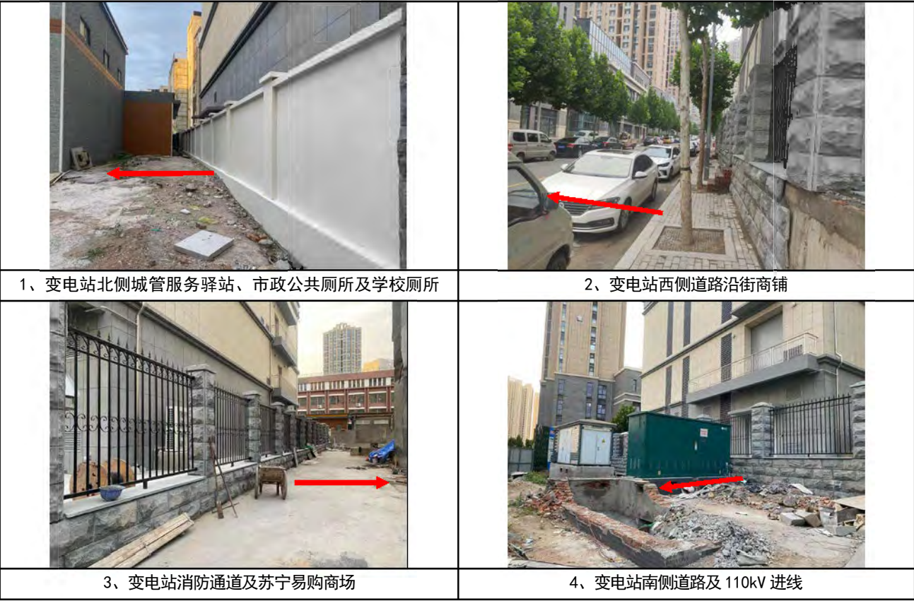
图 4-1 本工程变电站周围现场照片
