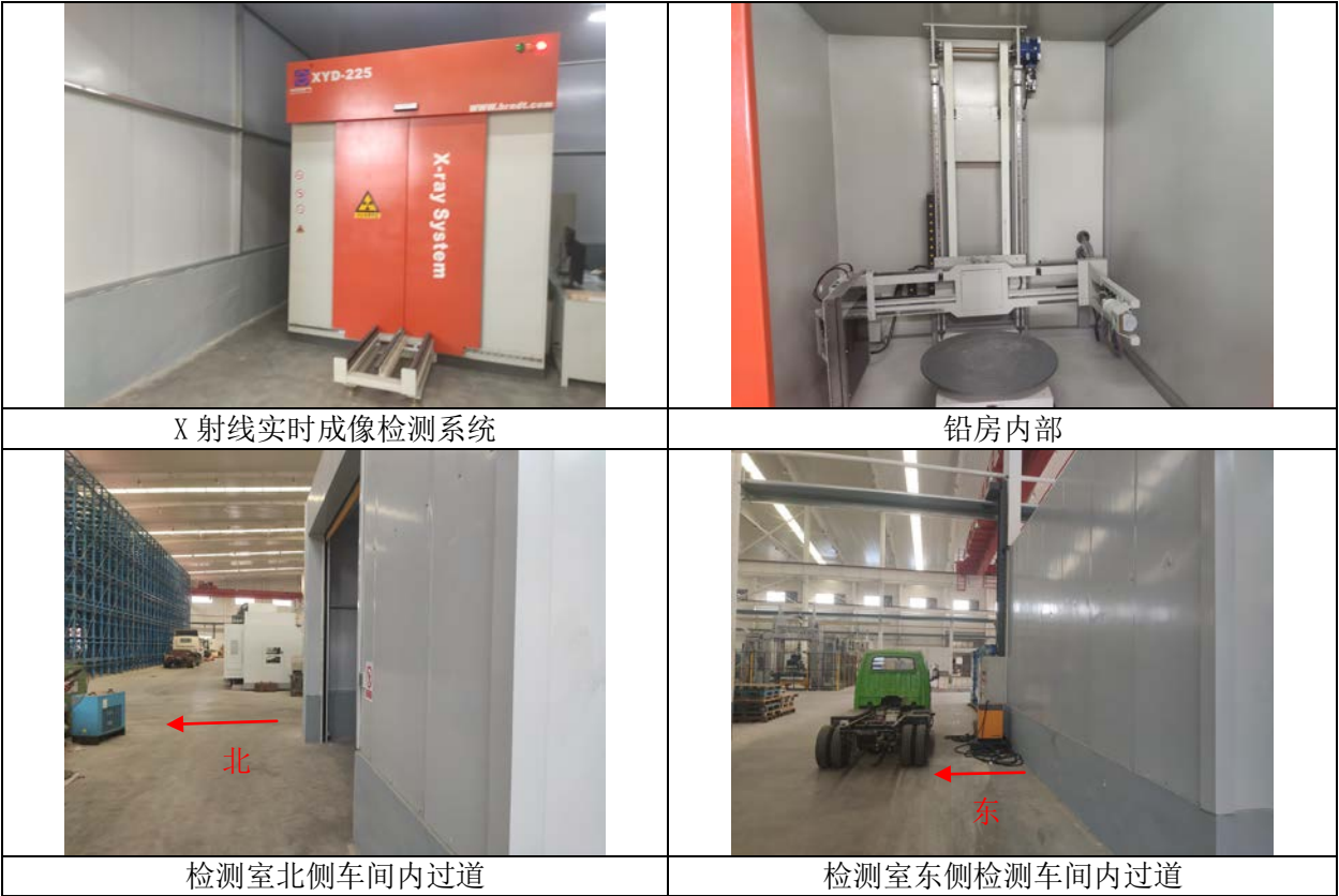
图 2-1 本次验收 X 射线实时成像检测系统及检测室现场照片
