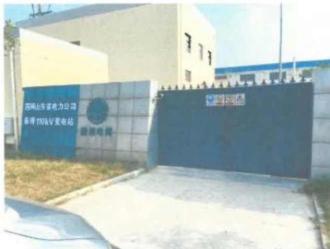
项目现场照片
