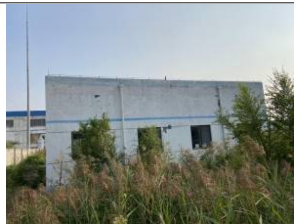
2. 变电站西侧 6m 山东华盛荣镁业科技有限公司配电室
