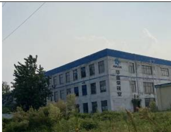
1. 变电站南侧 13m 山东华盛荣镁业科技有限公司宿舍楼
