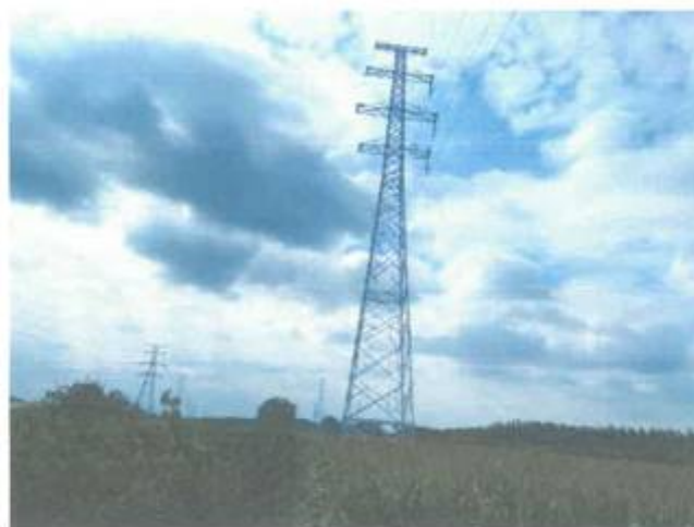
项目现场照片
