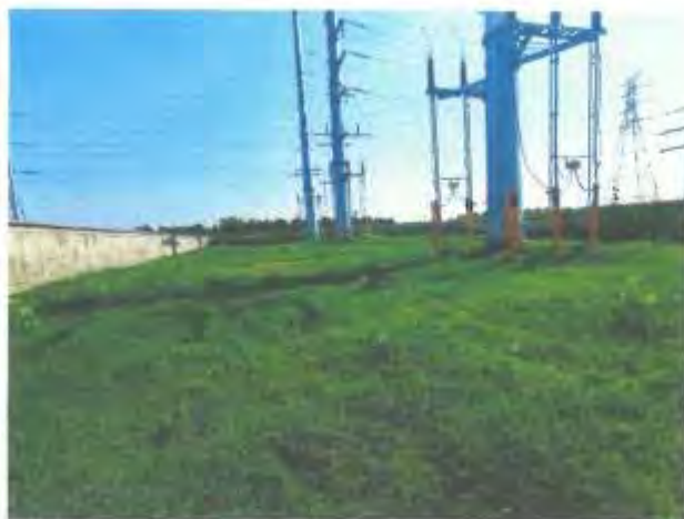
项目现场照片
