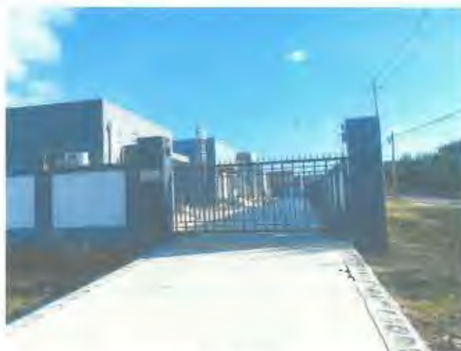
项目现场照片
