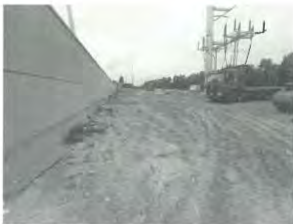
项目现场照片
