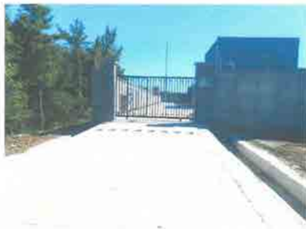
项目现场照片
