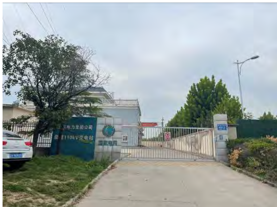
1. 110kV 豪德站大门
