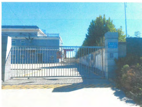
项目现场照片
