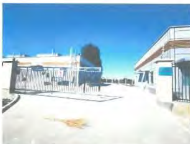
项目现场照片
