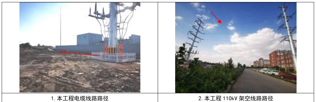
图 4-2 本工程输电线路周围现场照片
