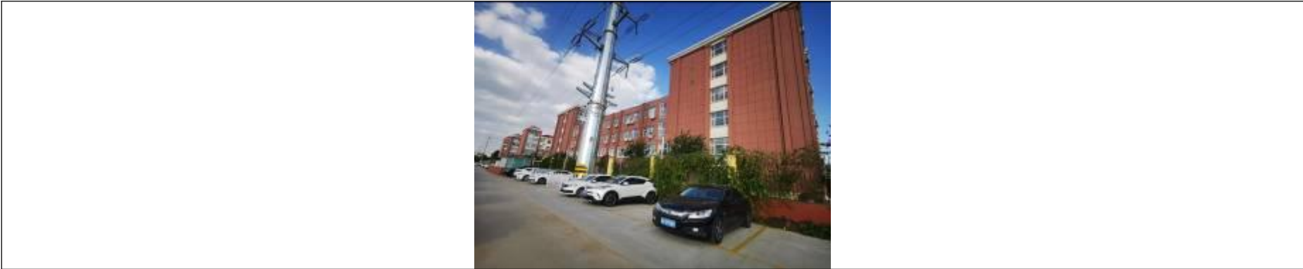
1. 110kV 宝恒线 22 号~110kV 宝恒线利民支线 1 号(110kV 宝桂 II 线 101 号~110kV 宝桂 II 线利民支线 1 号)塔间线路东侧 15m 昌乐一中英才实验学校
