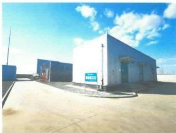
项目现场照片
