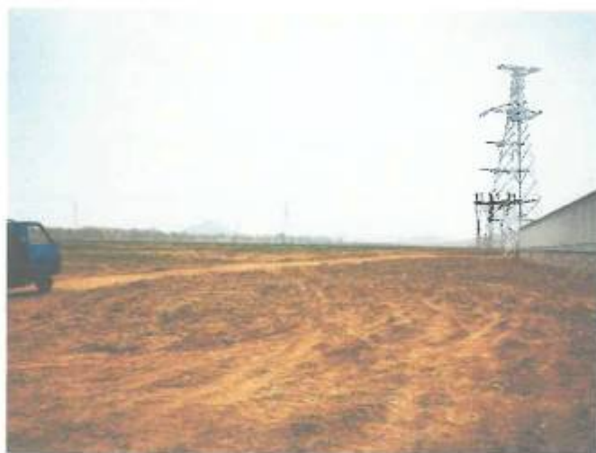
项目现场照片
