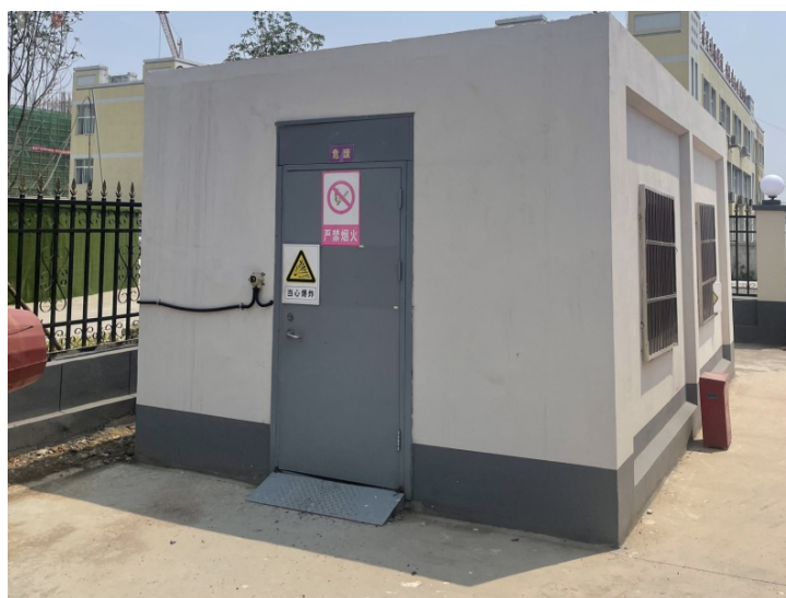
图 2-4 危废暂存间现场照片
