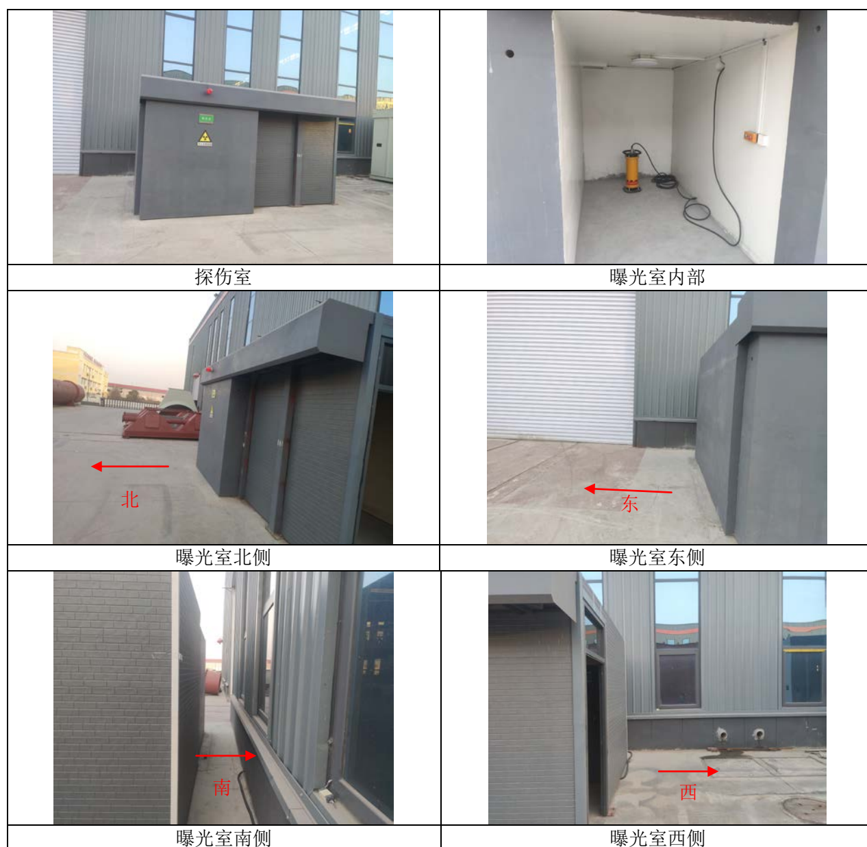
图 2-1 本次验收探伤室现场拍摄照片
