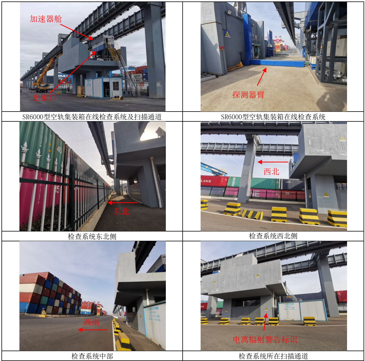
图 2-1 SR6000 型空轨集装箱在线检查系统现场照片
