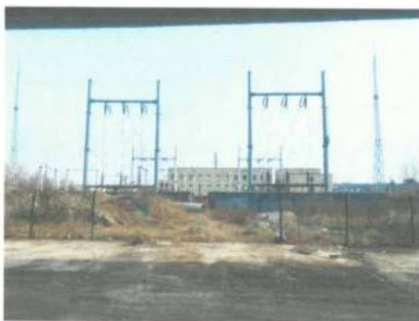
项目现场照片
