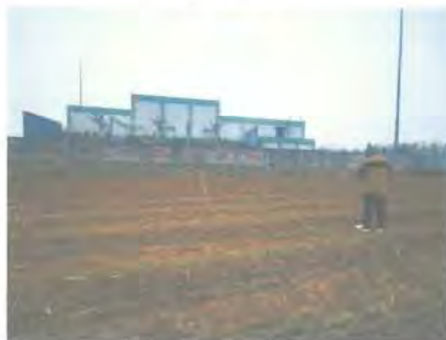
项目现场监测照片
