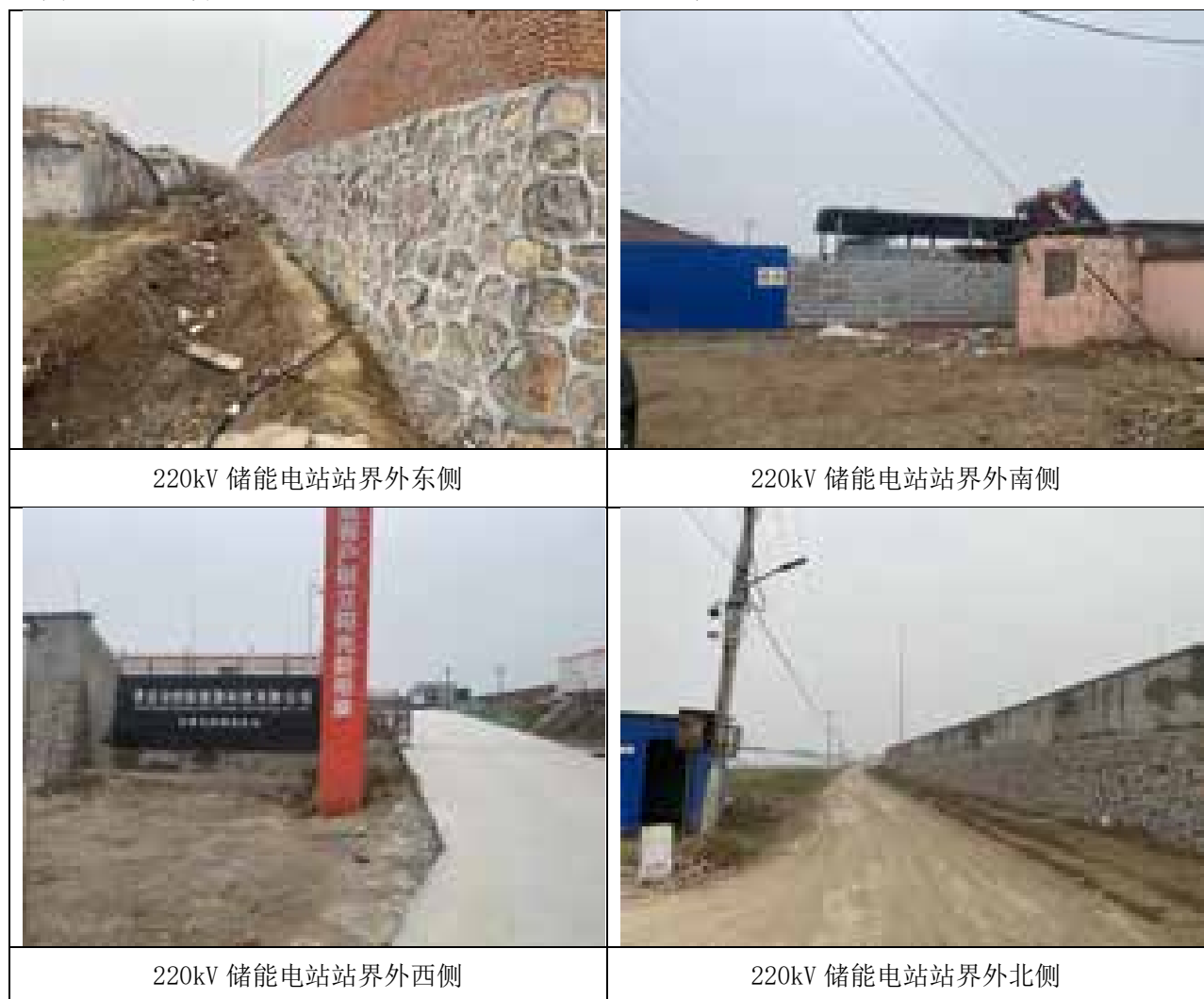
图 4-1 220kV 储能电站周围现场照片（拍摄于 2023 年 2 月）
