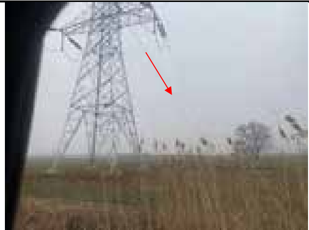
图 4-2 220kV 输电线路周围现场照片(拍摄于 2023 年 2 月)
