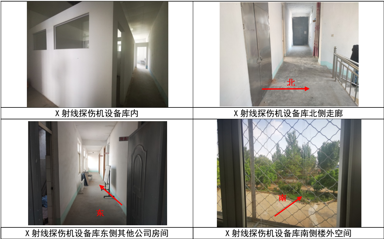
图 2-5 设备库周围现场照片
