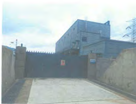
项目现场照片
