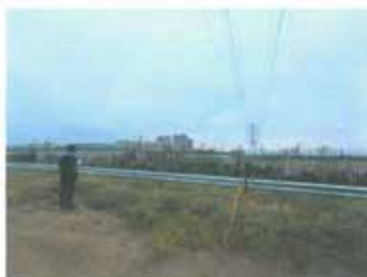
现场检测照片
