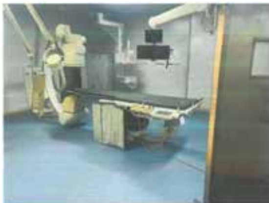
项目现场照片
