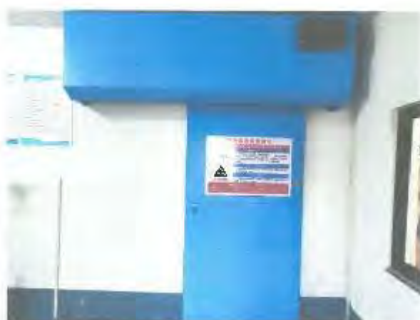
项目现场照片
