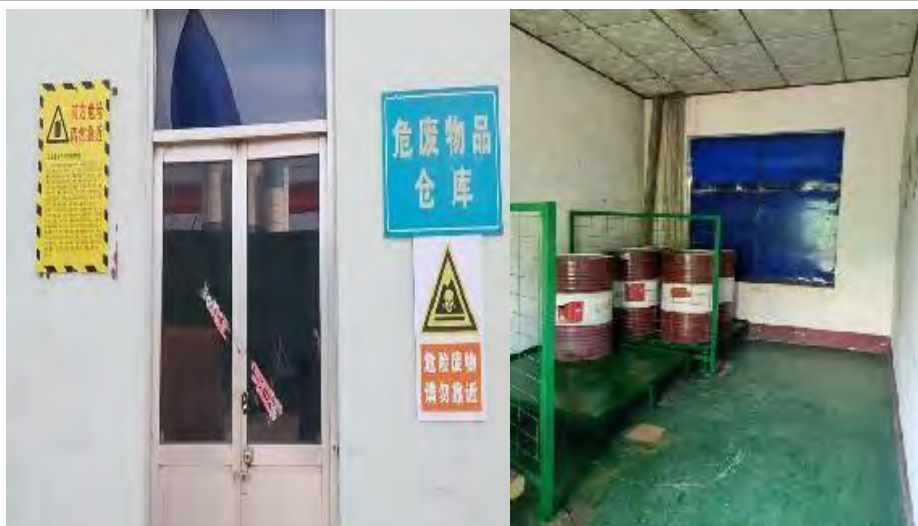
图 2-6 危废暂存间现场照片
