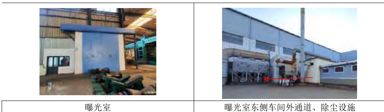
图 2-1 本项目现状照片
