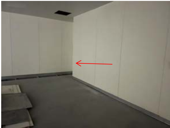
3#加速器治疗室西侧2#加速器治疗室（未建设完成）
