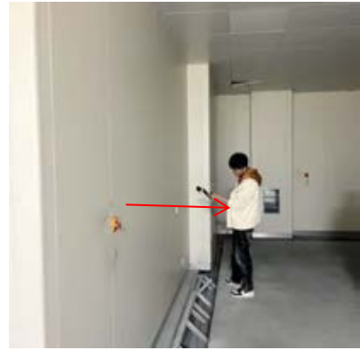
3#加速器治疗室东侧走廊
