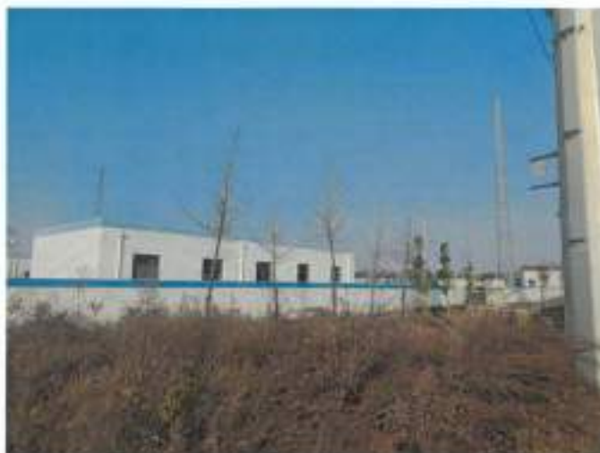
项目现场照片
